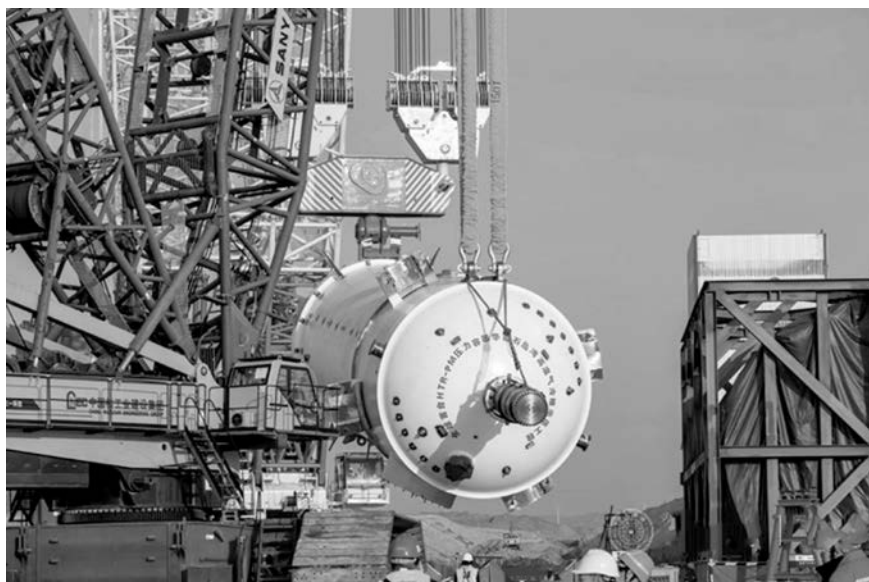
图 1.19 HTR-PM 第一座反应堆压力壳正在吊装就位
