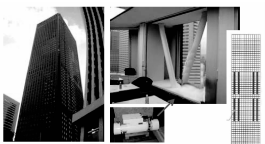
图 1-5 安装 288 个油阻尼器的日本建筑案例
