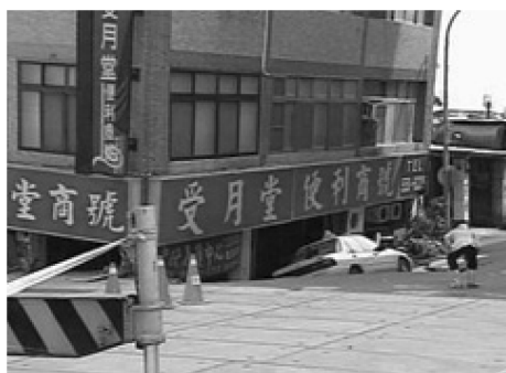
图3 台湾高雄地铁施工造成的楼房沉陷
