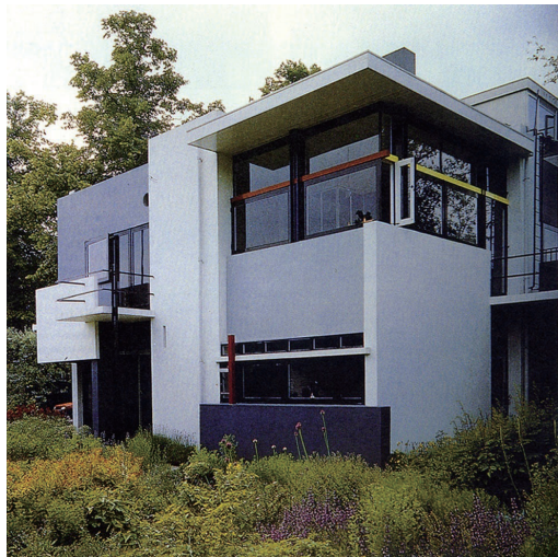
图1-3 施罗德住宅 里特维德
