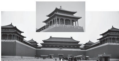
图 1.10 午门的四个角楼
