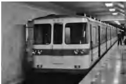
图 1-8 北京地铁1号线
