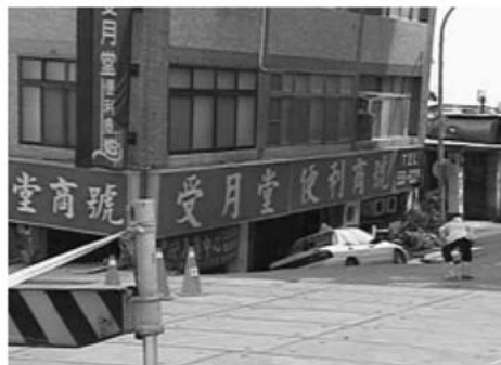
图 3 台湾高雄地铁施工造成的房屋沉陷
