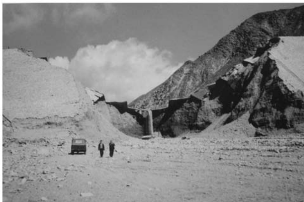
图5 青海省沟后水库大坝溃决
