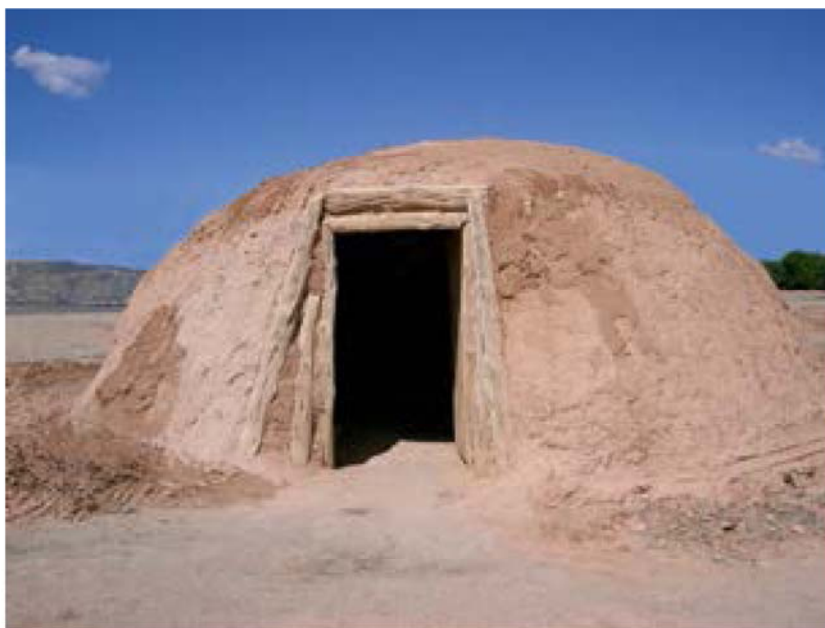
建造完成的土坯房屋
