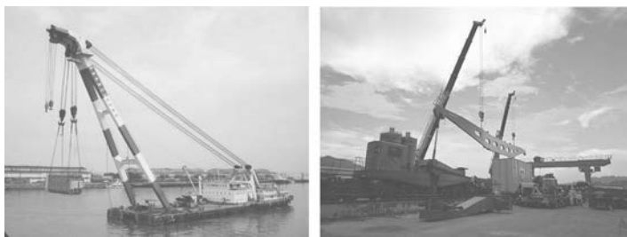
图 1-3 工程物流吊装起重
