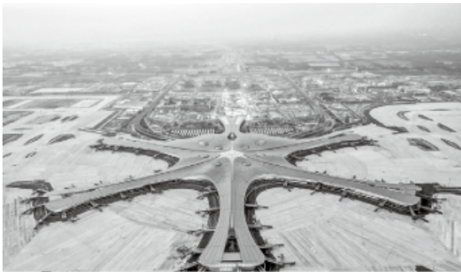
图 1.2 北京大兴国际机场
