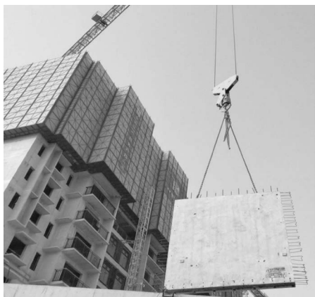
图 1-3 装配式混凝土结构建筑
