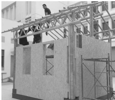
图 1-6 装配式竹结构建筑
