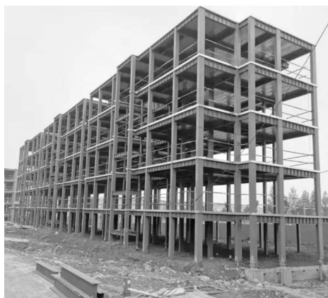
图 1-4 装配式钢结构建筑
