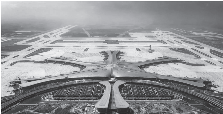
图 1-2 北京大兴国际机场
