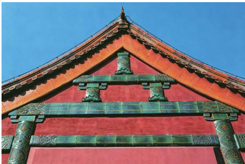
北京紫禁城的硬山顶建筑
