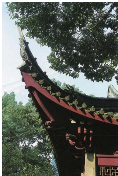
屋顶高翘角的结构
