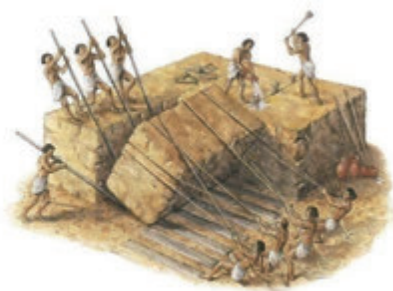
图 1.12 古埃及使用原木和杠杆搬运建造金字塔的石块
